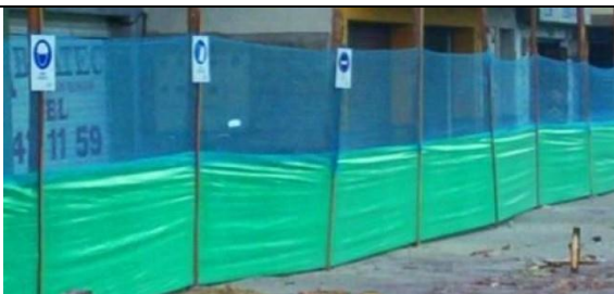
Malla cerramiento Obra
