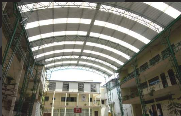
► Cubierta Colegio La Divina Providencia
