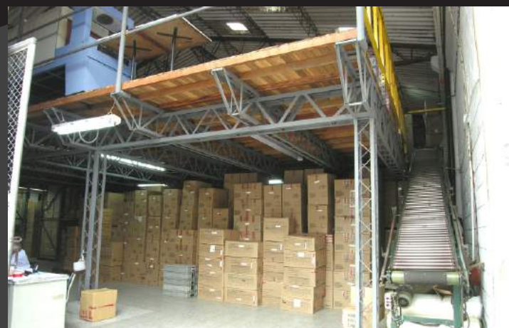
► Mezanines Fabrica de Calzado Manisol
