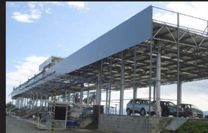
► Estructura Concesionario Casautos - Pereira (Vía a Cerritos)
