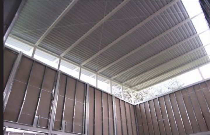
► Estructura General Cancha de Squash Edif. Mirador de La Colina
